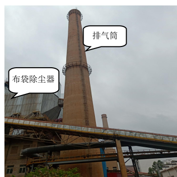
1#窑尾布袋除尘器、排气筒
