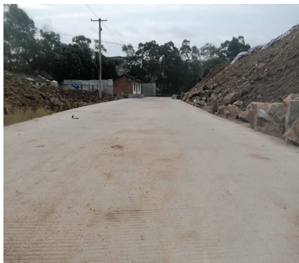
运输道路路面硬化
