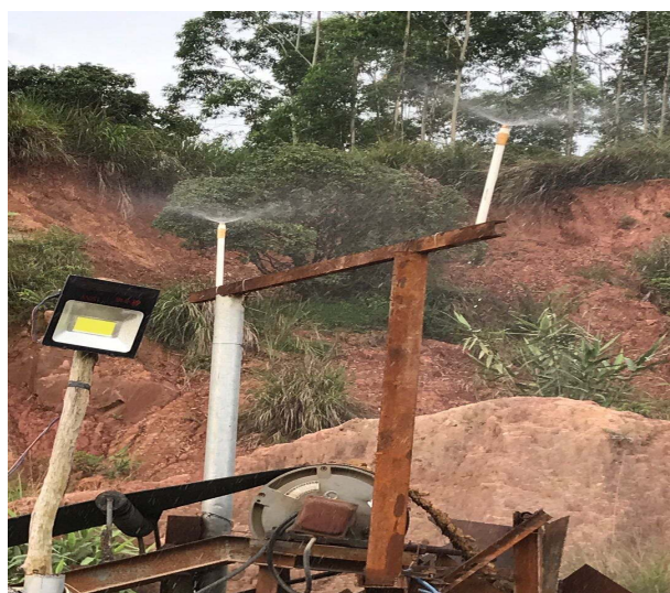
破碎喷淋装置
