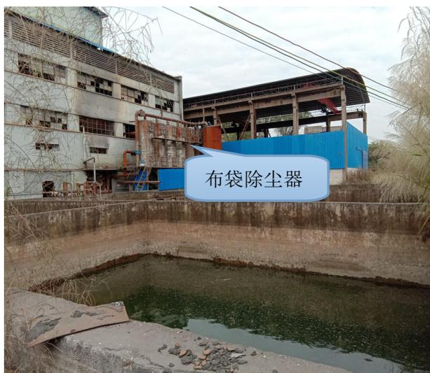
熔炼炉工序布袋除尘器
