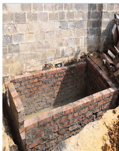
东面雨水收集池
