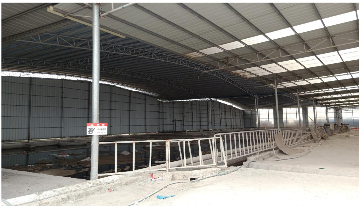
污水处理系统
