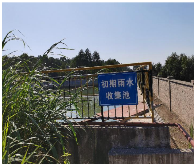
初期雨水收集池
