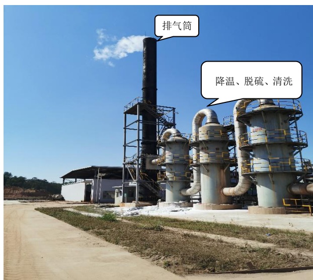
回转窑废气处理设施
