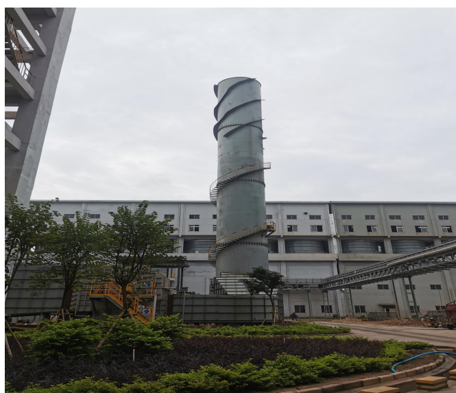
烧结机尾排气筒
