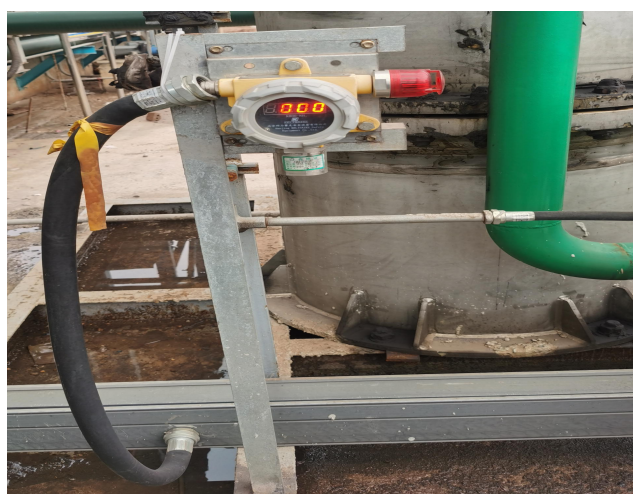
氨气固定式气体检测变送器
