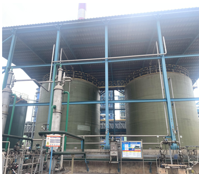
氨水罐围堰
