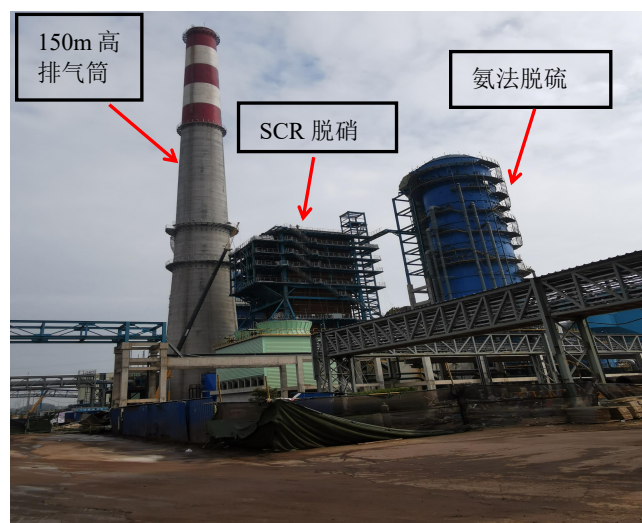
烧结机头：氨法脱硫+SCR 脱硝
