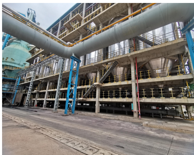
高炉煤气：重力除尘+干式布袋除尘
