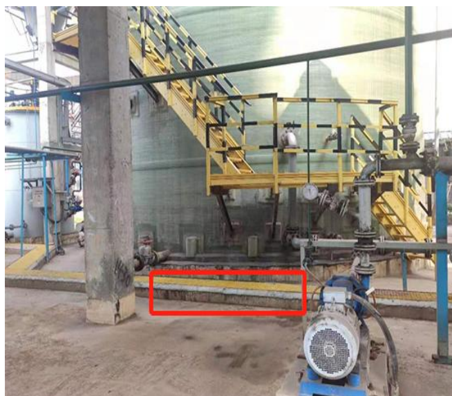
氨水罐导流沟
