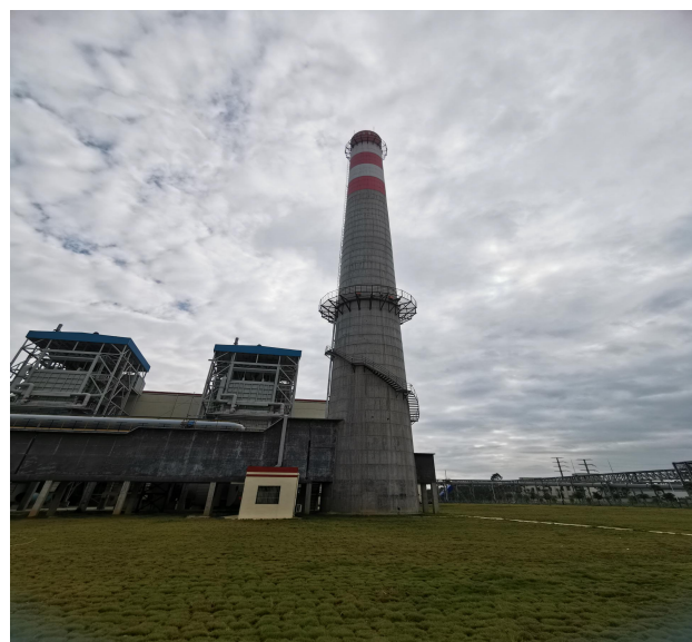
煤气发电锅炉废气排气筒
